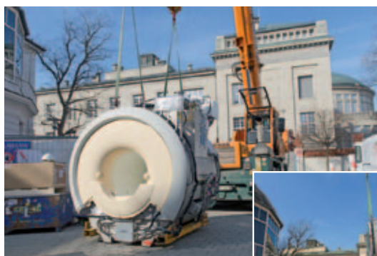
Das MRT bei der Anlieferung per Kran
